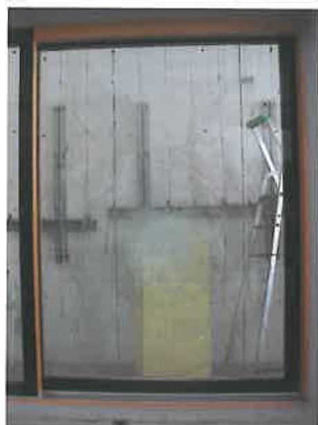
Particolare della rottura.
