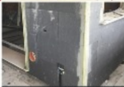
Murature esterne con isolamento a cappotto.
